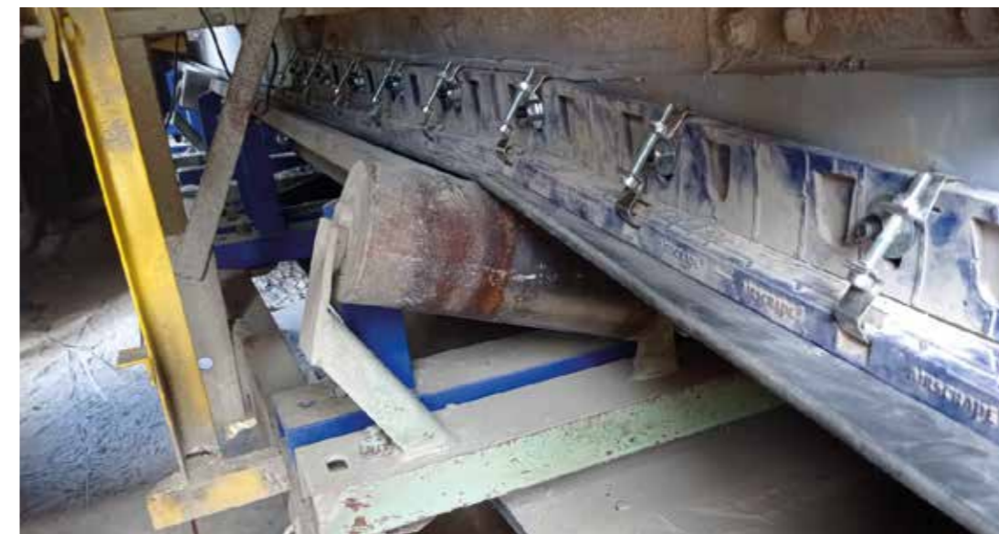
Ausstattung einer Übergabe mit dem AirScrape in einem Zementwerk in Spanien
