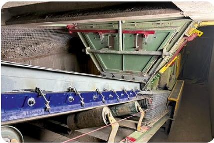
Después de la instalación: El polvo y los vertidos se reducen en un 95% o más tras la instalación de AirScrape®, TailScrape y K-Containment® Seal.
