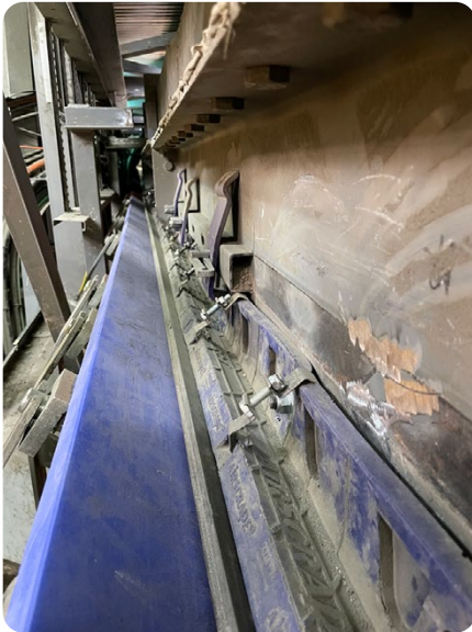
Instalación de AirScrape y SureSupport. Esta combinación mejora la absorción del material y garantiza un sellado óptimo.
