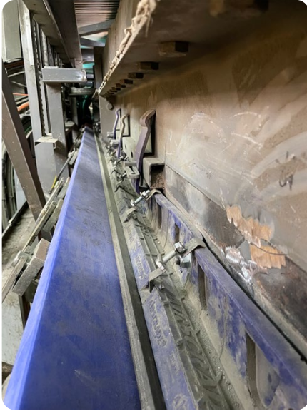
Installation von AirScrape und SureSupport. Diese Kombination verbessert die Materialaufnahme und gewährleistet eine optimale Dichtigkeit.
